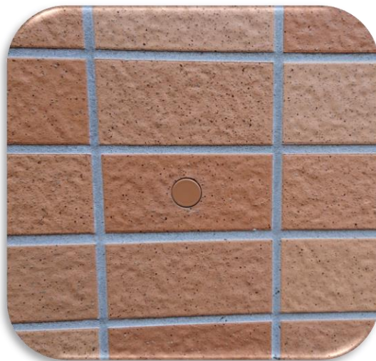
GOODキャップ施工後
